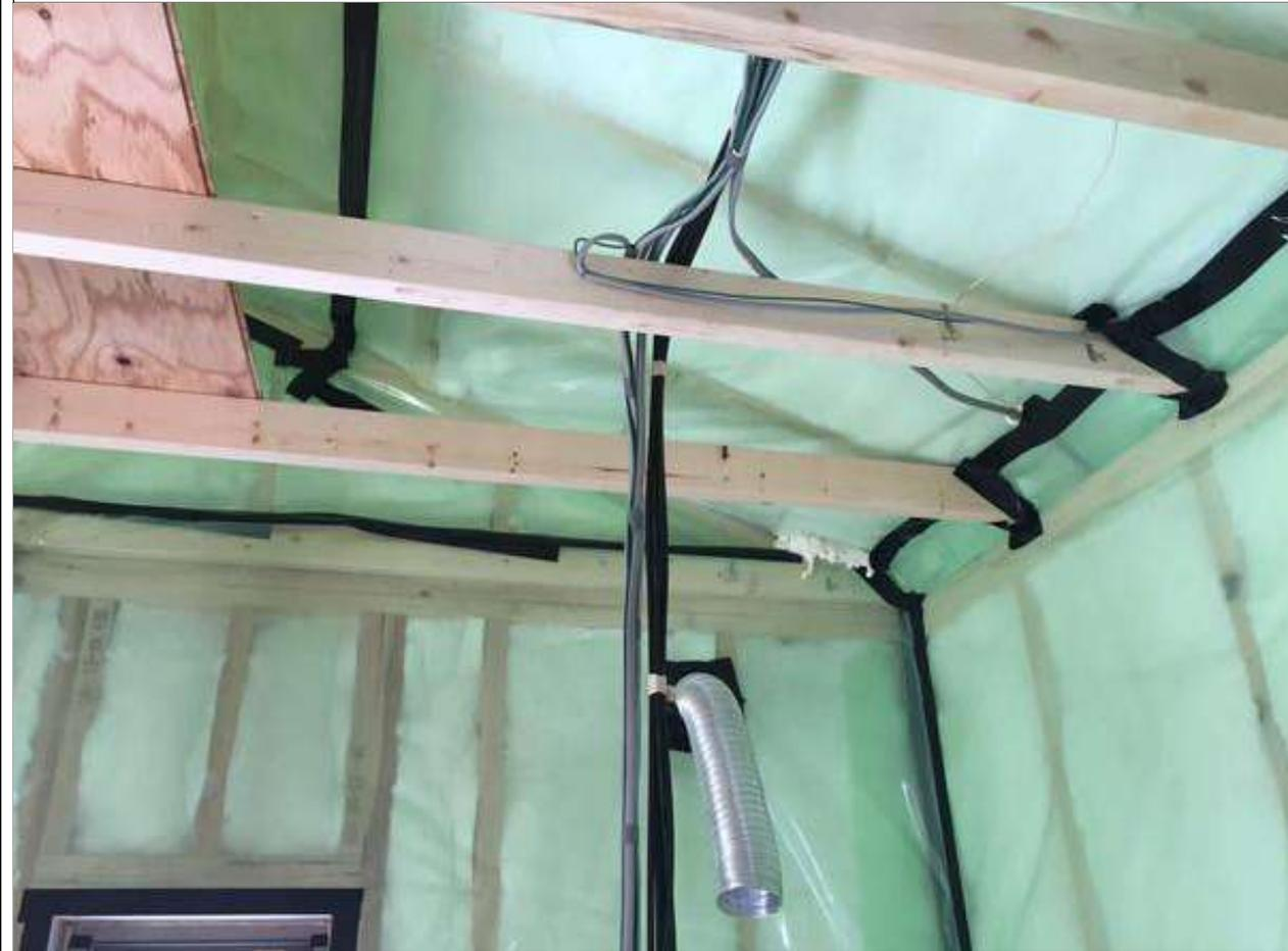
2-3口断熱材は隙間・欠損・施工不良がないように施工する。断熱材は配管部分に隙間ができないように気を付ける。(1/2)
