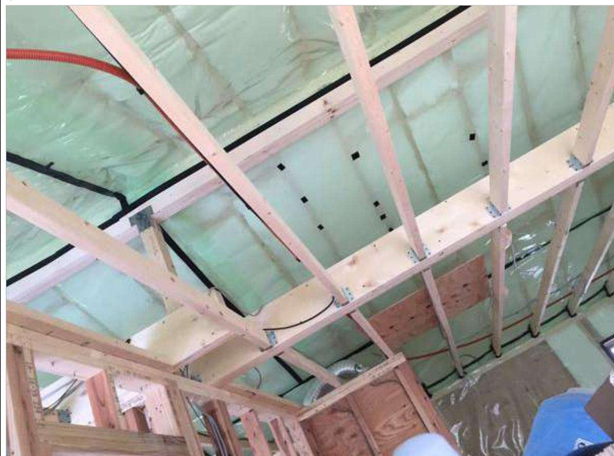
2-5口防湿層（気密シート）は幅広の長尺シートを用い、連続させ、隙間の出ないように施工する。継ぎ目は下地材のある所で30mm以上重ね合わせる。（2/2）
