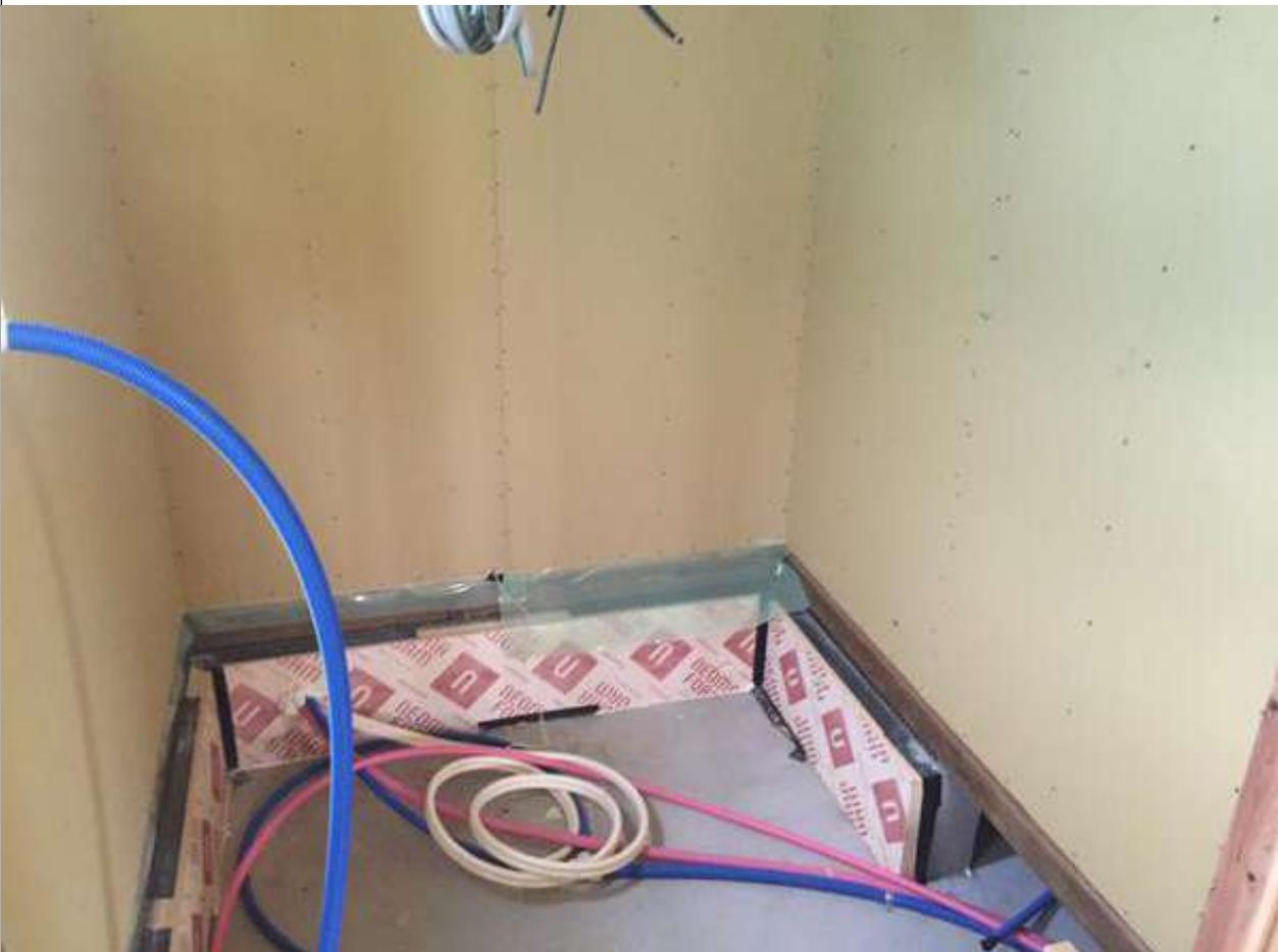
2-5口防湿層（気密シート）は幅広の長尺シートを用い、連続させ、隙間の出ないように施工する。継ぎ目は下地材のある所で30mm以上重ね合わせる。（1/2）
