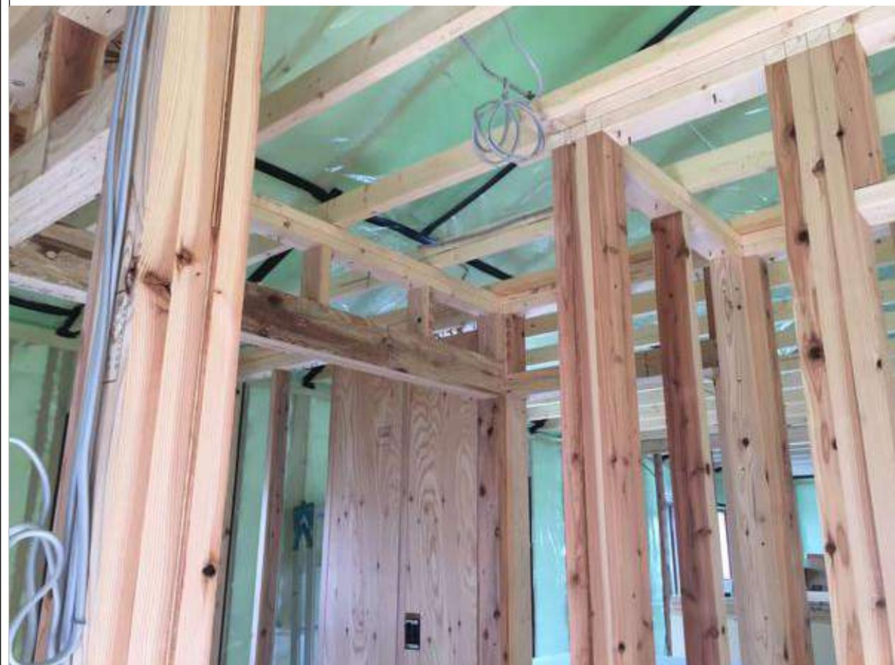
2-3口断熱材は隙間・欠損・施工不良がないように施工する。断熱材は配管部分に隙間ができないように気を付ける。(2/2)
